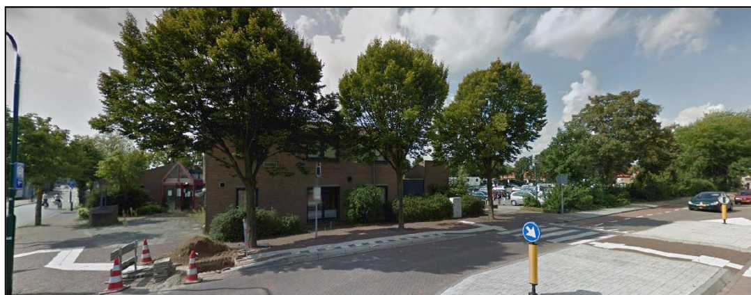
Rechter zijgevel kantoorgebouw Zwaanplein
