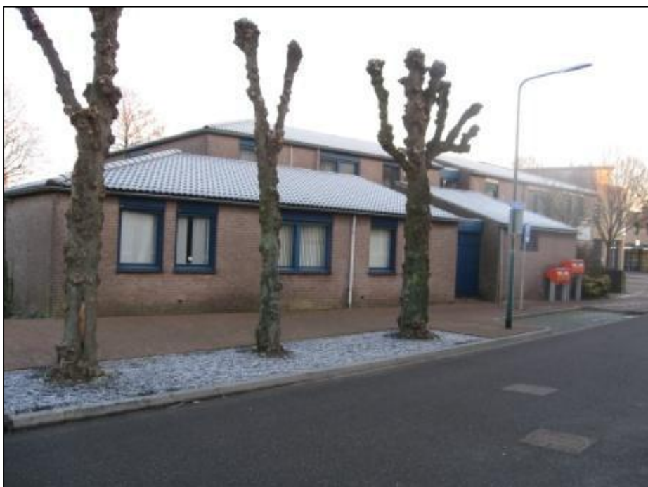
Figuur 3. Impressie pand op de onderzoekslocatie.
