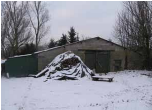
Sloop- en asbestsanering stal 71 m 2
