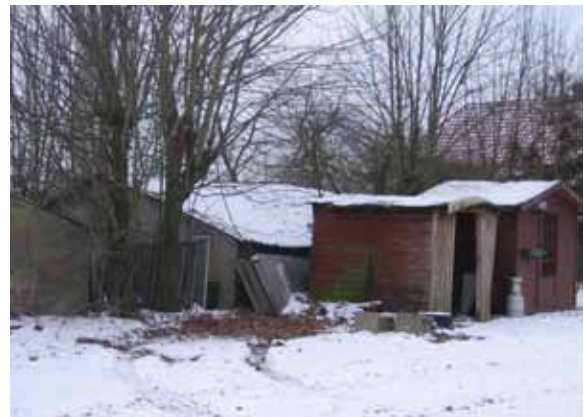
Sloop- en asbestsanering 78 m 2
