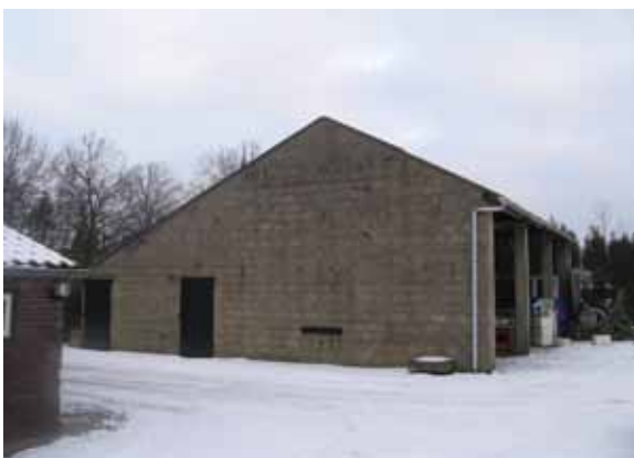
asbestsanering stal 141 m 2
