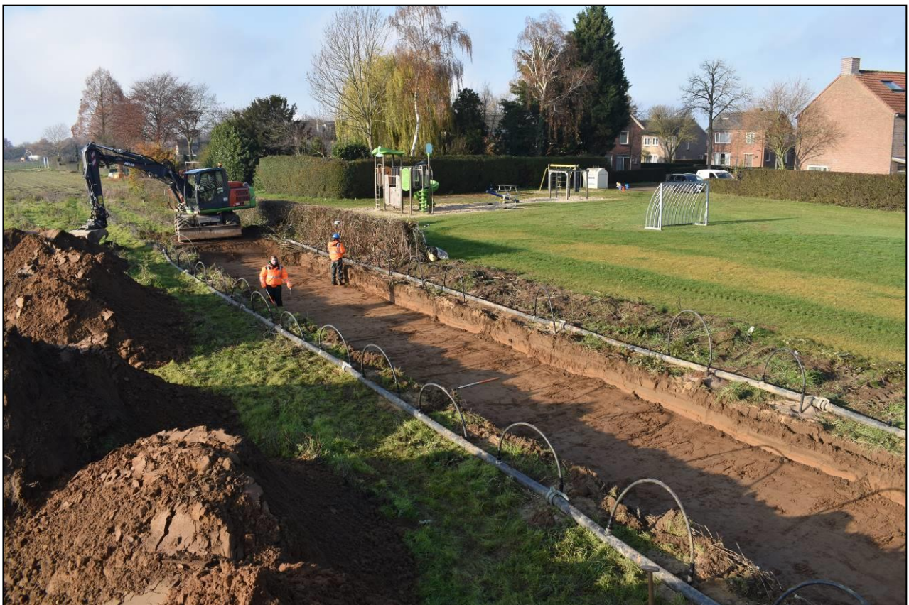
Figuur 8: Zicht op werkput 1, gefotografeerd in noordwestelijk richting.
