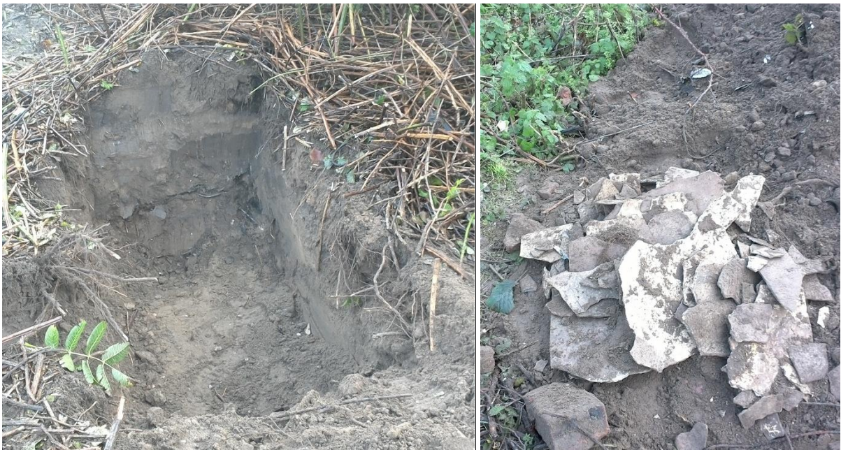
Figuur 3: Foto's aangetroffen asbesthoudend materiaal ter plaatse van proefsleuf 5
