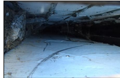
Figuur 11. Ruimte tussen binnenwand en betimmering.
