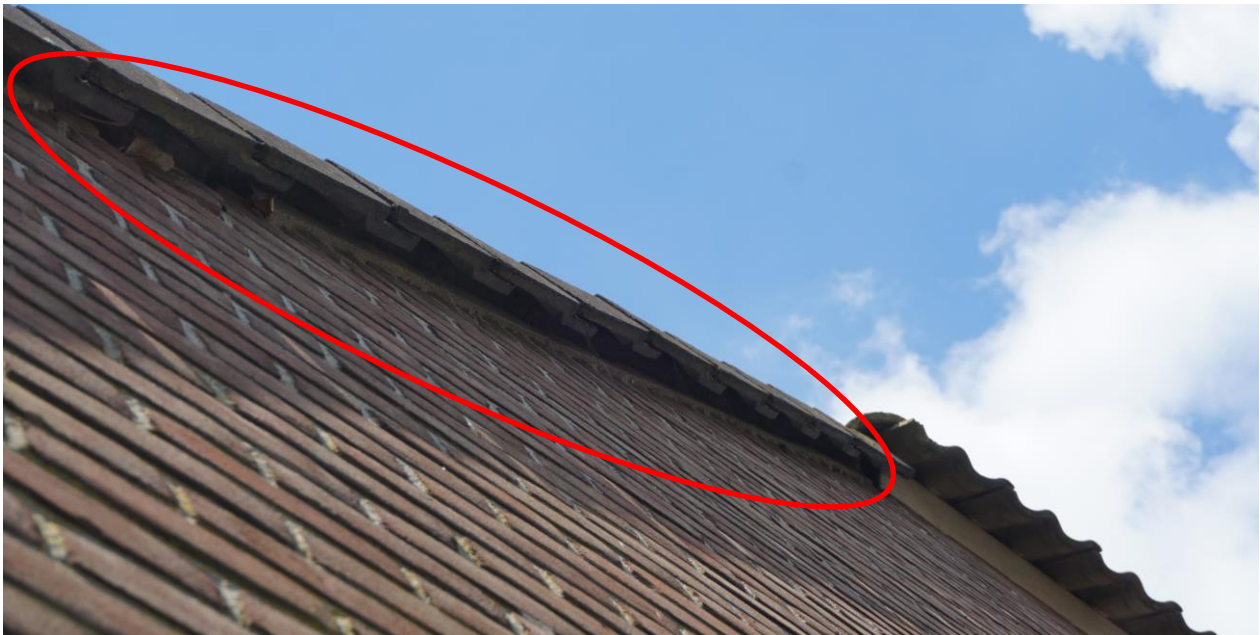
Figuur 4.4 De kantpannen van het woninggedeelte aan de Nuisveen 1 bieden ruimte voor gierzwaluw om onder het dak tot broeden te komen.
