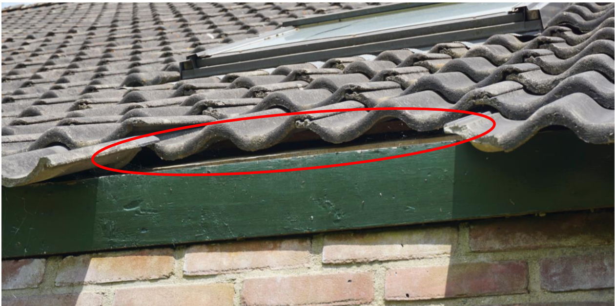
Figuur 4.6 Via de eerste rij pannen kunnen huismussen in het dakvlak van Nuisveen 1 tot broeden komen.
