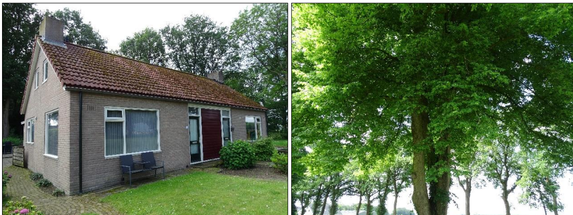
Foto 7. Het dakpannen dak van de woningen nr 23 en 25 met openingen langs de kantpannen. Foto 8. Dichte bladerdek van de grote lindeboom in het noordwesten van het plangebied.
