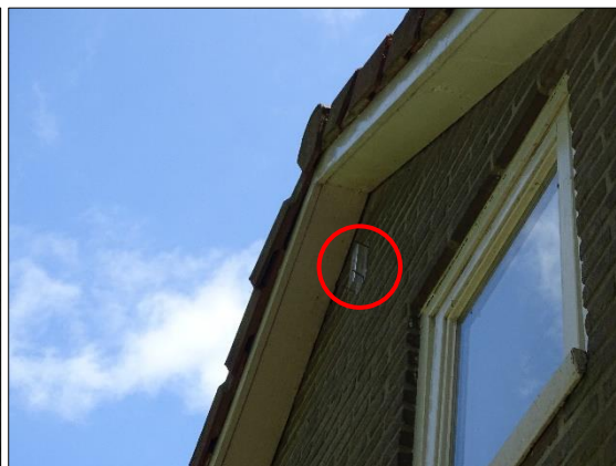
Foto 11. Een 'exclusion flap' op een stootvoeg van woning nummer 25. Foto 12. Een 'exclusion flap' op een stootvoeg in de nok van woning nummer 25. Bij de kantpannen zijn geschikte openingen te zien.
