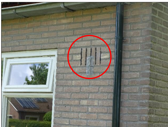
Foto 11. Een 'exclusion flap' op een stootvoeg van woning nummer 25. Foto 12. Een 'exclusion flap' op een stootvoeg in de nok van woning nummer 25. Bij de kantpannen zijn geschikte openingen te zien.
