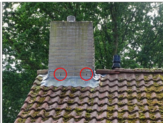
Foto 9. Open stootvoegen in muren van woning nummer 23. Foto 10. Open stootvoegen in de schoorsteen van de woning nummer 23.
