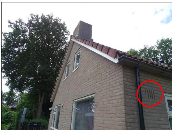
Foto 9. Open stootvoegen in muren van woning nummer 23. Foto 10. Open stootvoegen in de schoorsteen van de woning nummer 23.
