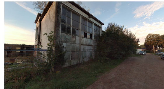
Oude melkfabriek gelegen aan de Fabrieksstraat.
