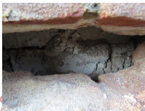
Figuur 10: open gemaakte gevel Jan Fabriciusstraat 1, restanten UF schuim
