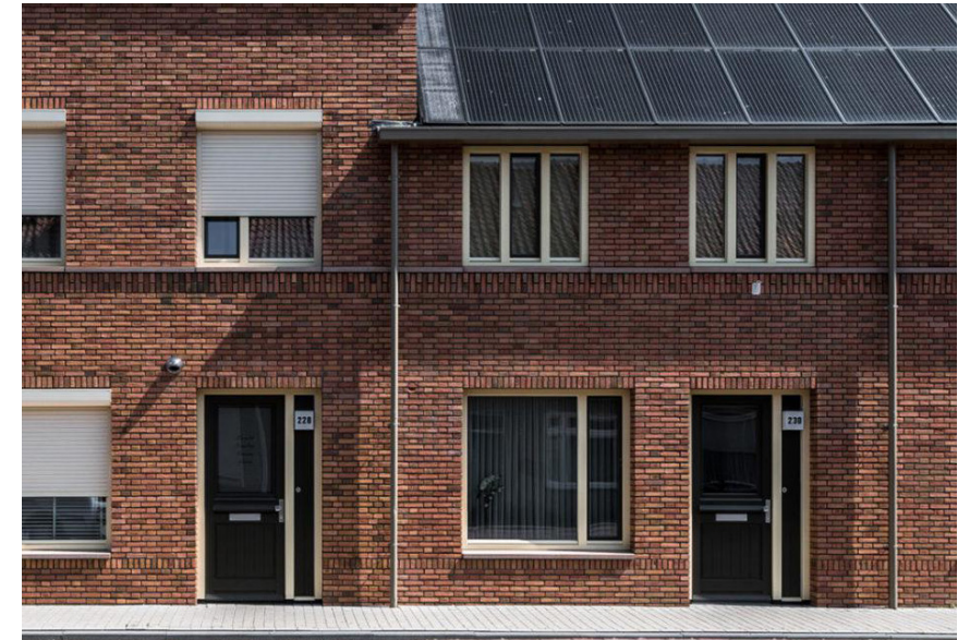
REFERENTIE: bruinrood metselwerk, pv-panelen zorgvuldig ingepast
