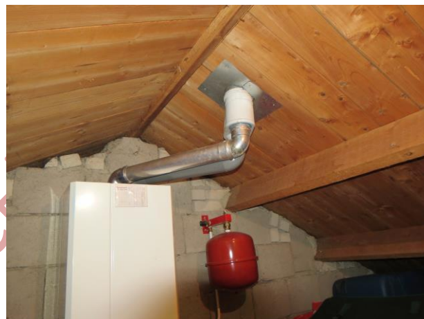
Figuur 16: zolder bij woningscheidende wand
