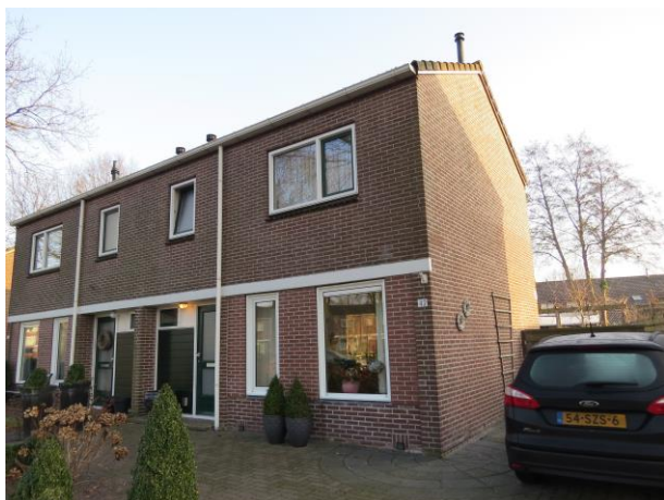
Figuur 2: Anne de Vriesstraat 42 voorgevel en zijgevel
