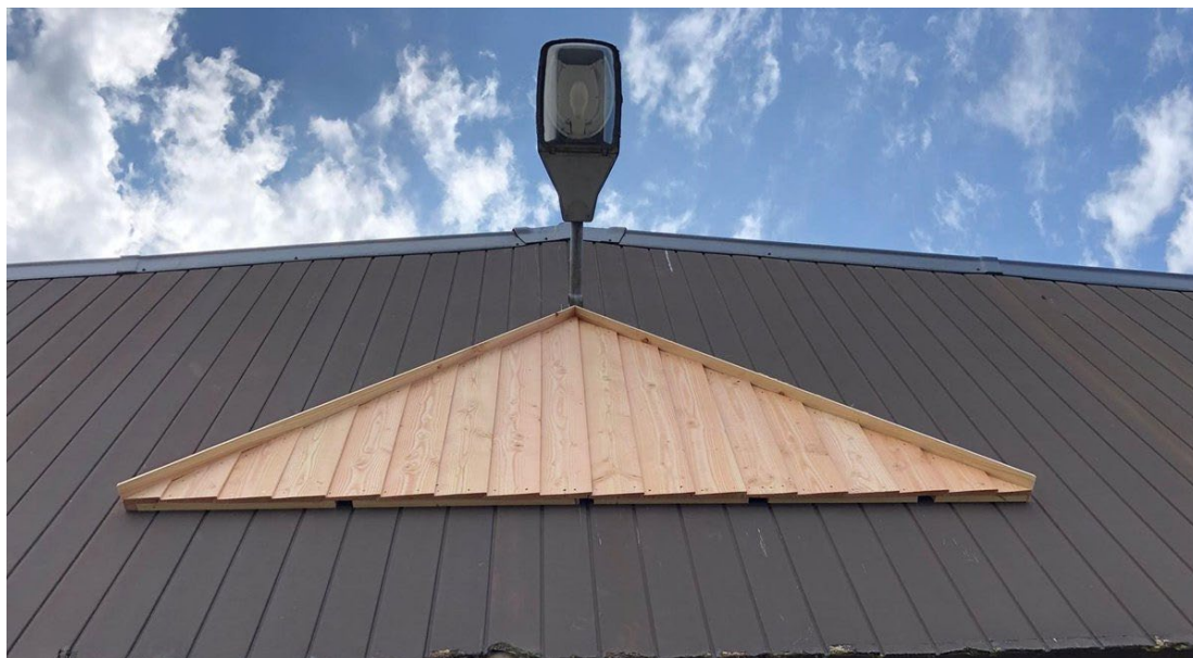
Figuur 5.2 Voorbeeld van een voor de laatvlieger geschikte gevelbetimmering. Op de linkerfoto blijft de verlichting overigens uit. Dit is een aandachtspunt als het gaat om de locaties voor de gevelbetimmeringen.
