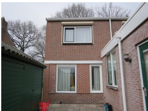
Figuur 7: Jan Fabriciusstraat 2, achtergevel
