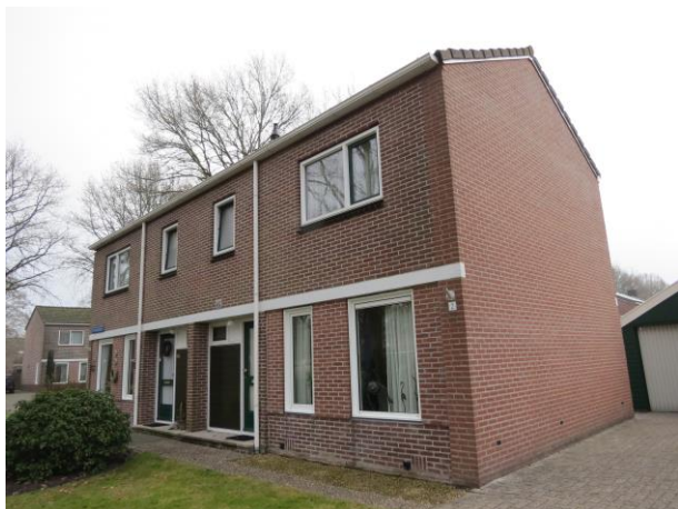
Figuur 6: Jan Fabriciusstraat 2, voorgevel en zijgevel
