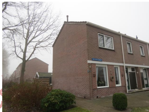
Figuur 4: Jan Fabriciusstraat 1, voorgevel en zijgevel
