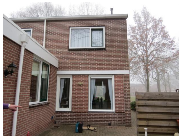
Figuur 5: Jan Fabriciusstraat 1, achtergevel
