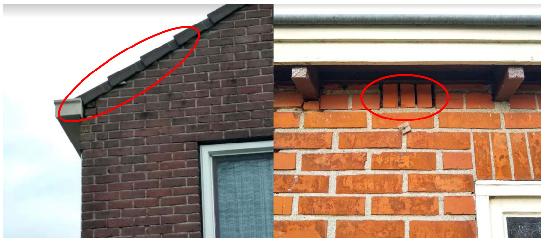
Figuur 3.1: Geschiedte invliegopeningen voor vleermuizen. Links: Openingen achter de dakgoot en onder de dakrand. Rechts: Open stootvoegen die toegang bieden tot een geschikte verblijfplaats
