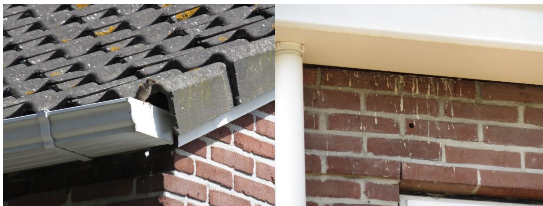
Figuur 3.2 Nestplaatsen van huismussen achter de dakpannen en achter dakgoten
