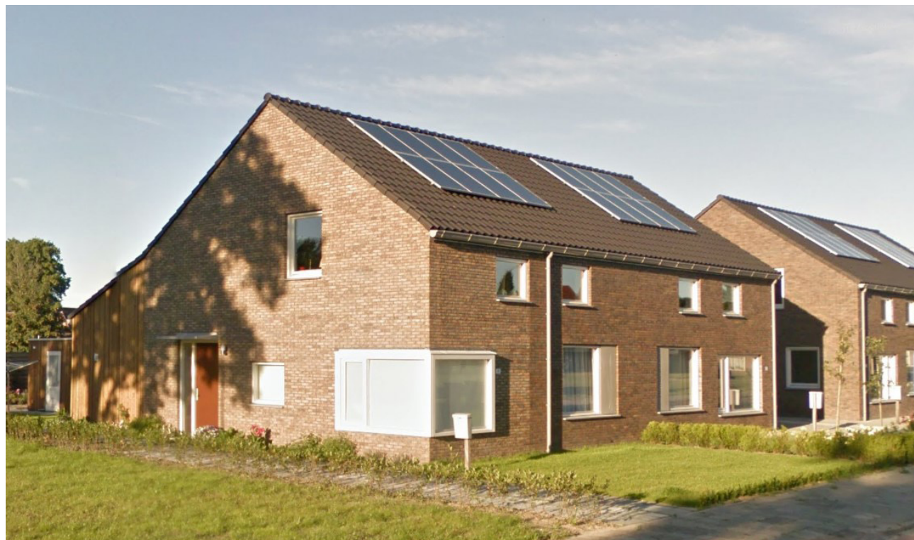
REFERENTIE: zijgevel als tweede kopgevel: overhoeks kozijn, open zijtuin met entree
