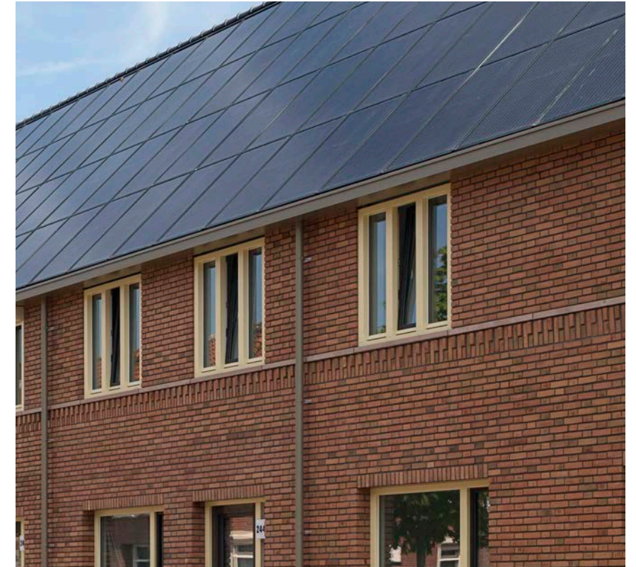
REFERENTIE: PV-panelen zorgvuldig meegenomen in ontwerp
