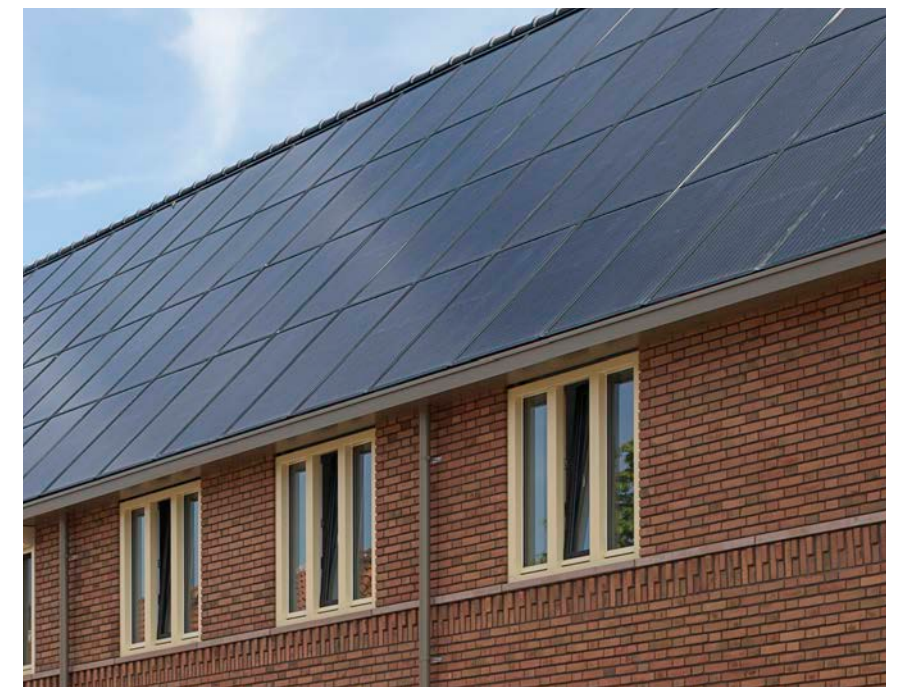
REFERENTIE: eenvoudige, zorgvuldige gootdetaillering en positionering pv-panelen
