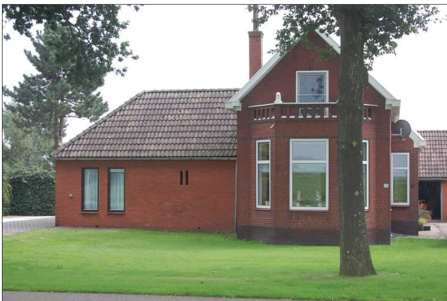
Deze woning van het kenmerkende 'krimptype' heeft door de aanbouw sterk aan waarde ingeboet
