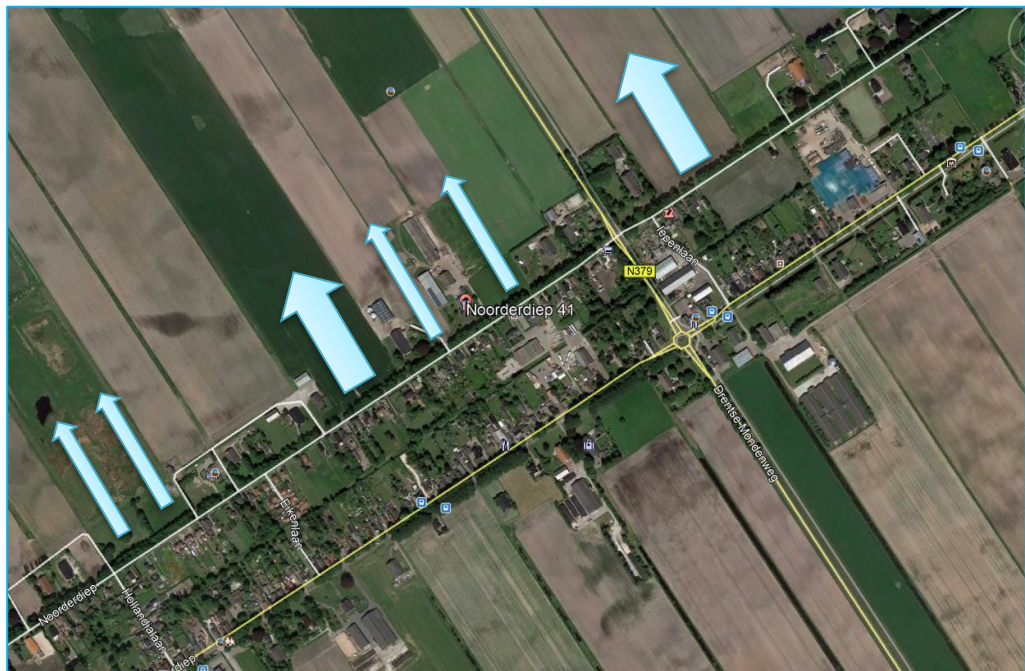
Figuur 3.4 Luchtfoto met doorzichten na realisatie nieuwe pluimveestal
