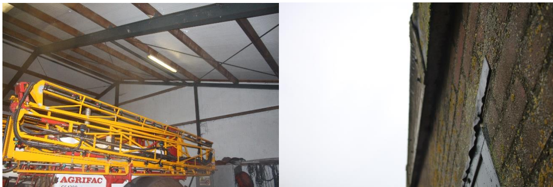
Figuur 4. Detailfoto. Gebouw C van binnen en dichtgewerkte gevel van stal E.
