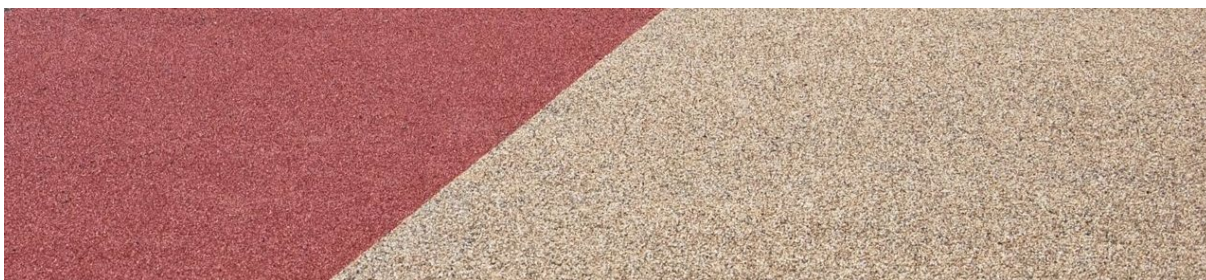
7 Hoofdroutes; fiets-wandelpad; asfalt met twee kleuren deklagen (2 meter fietsbreedte, 1,5 meter wandelbreedte)
