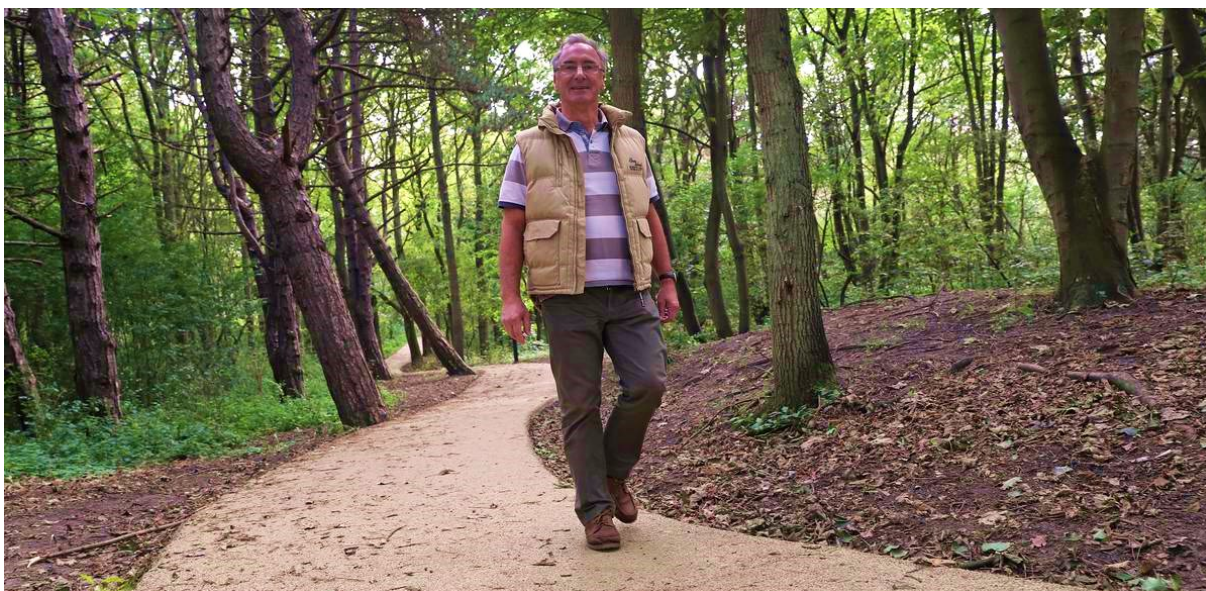
8 Wandelpaden, zandkleurig asfalt opf beton
