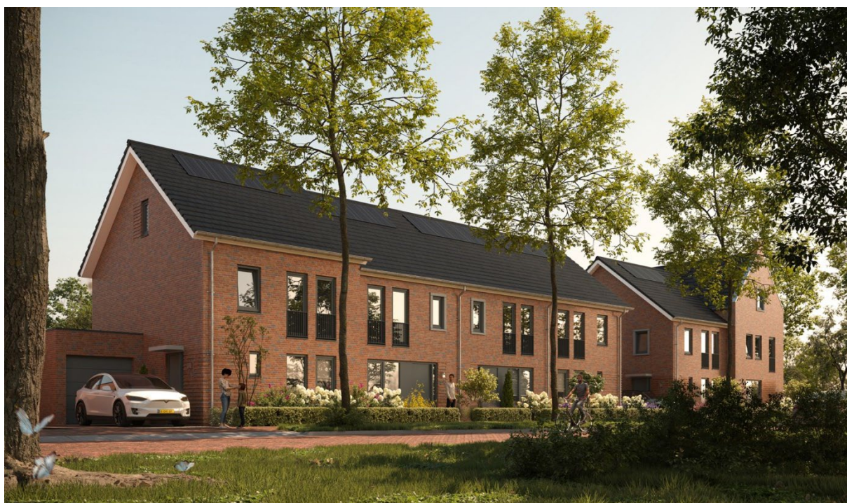
1 Wonen aan een straatprofiel met laanbomen
