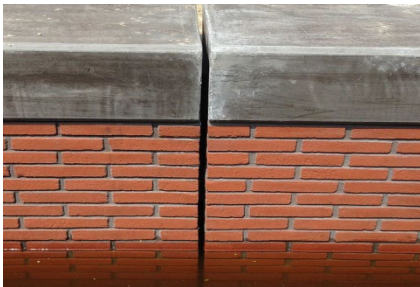
11 Damwand speelbastion (Prefab beton met voormetseling of met steenprint(Efko))
