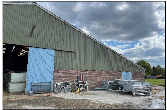
Afbeelding 2.3. Voorzijde (noord) te slopen stal.
