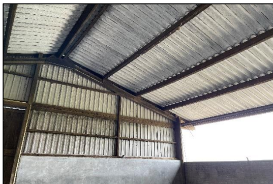
Afbeelding 2.8. Binnenzijde bijgebouw zuidzijde.
