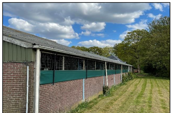
Afbeelding 2.5. Westzijde te slopen stal.
