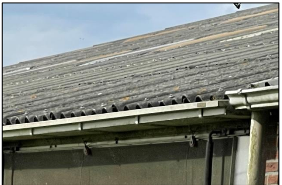
Afbeelding 2.7. Golfplaten dak op stal.
