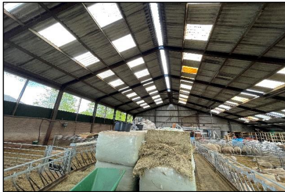
Afbeelding 2.2. Binnenzijde te slopen stal.
