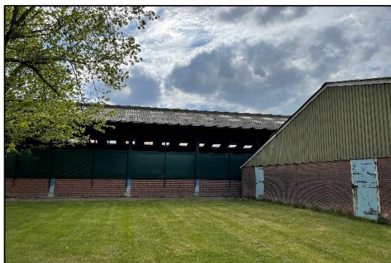
Afbeelding 2.4. Oostzijde te slopen stal met bijgebouw.
