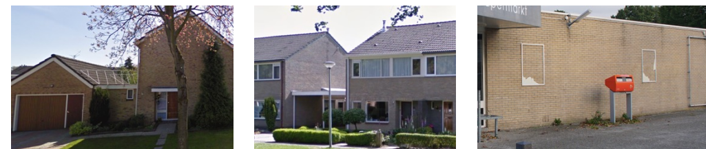
Gevelsteen in overeenstemming met de omliggende bebouwing waardoor het nieuwe gebouw vrijwel opgenomen wordt in de bestaande (gebouwde) omgeving
