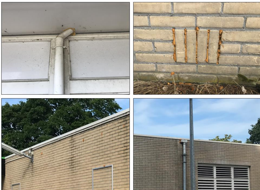
Figuur 3 De openingen in de bebouwing, zoals ventilatierooster, open stootvoegen en kieren langs regenpijpen zijn opgevuld met pur.
