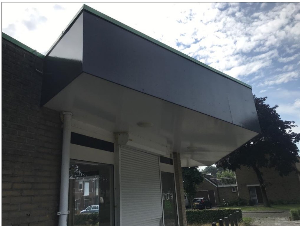
Figuur 2 De ingang van het te slopen winkelpand.
