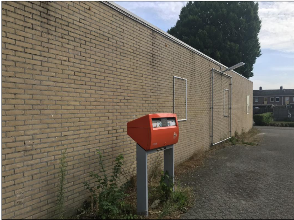
Figuur 3 De zijgevel van het te slopen winkelpand.
