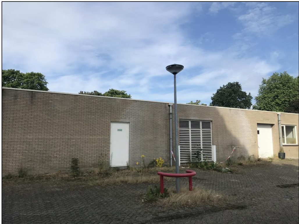
Figuur 4 De zijgevel van het te slopen winkelpand.
