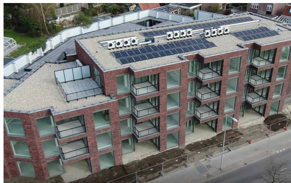
DAK INSTALLATIES MET VOLDOENDE AFSTAND TOT DE DAKRAND
