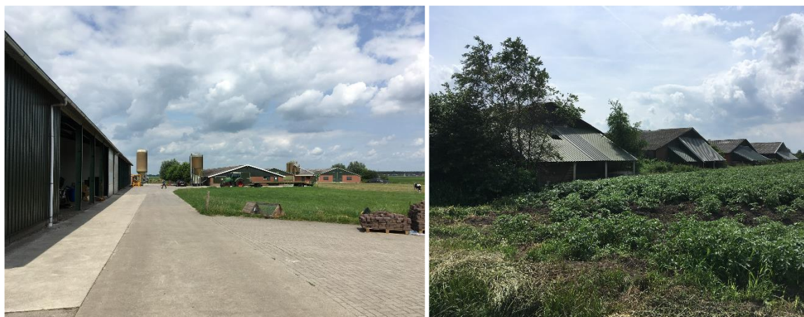
Indrukken van het plangebied, links: vooraanzicht van de stallen, links voor is de open kapschuur (1) te zien (zie plattegrond op de volgende pagina, rechts: achteraanzicht van de vier pluimveestallen (foto's: Laneco).
