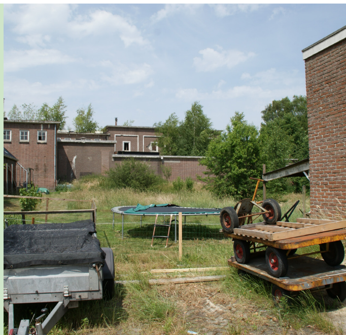
VERROMMELD TERREIN / ZICHT OP ACHTERZIJD FABRIEK
