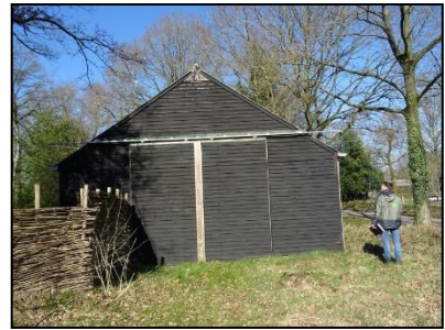
Figuur 11. Schuur (M) in het noordelijke deel van de onderzoekslocatie.
