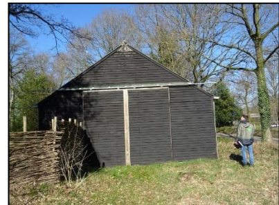
Figuur 28. Opslagschuur voor materialen en grasmaaiers.
