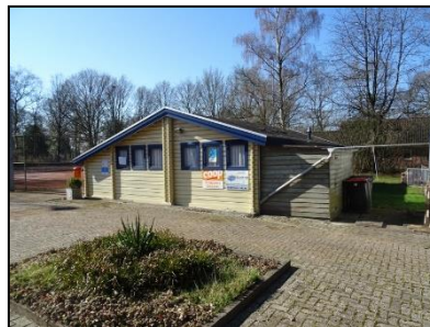
Figuur 4. Kantine van de tennisvereniging (B) in het noordwestelijke deel van de onderzoekslocatie.
