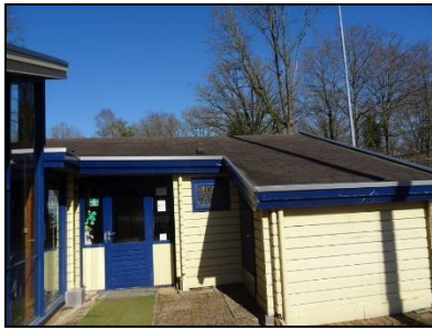
Figuur 23. Platte dakbedekking kantine tennisvereniging.
