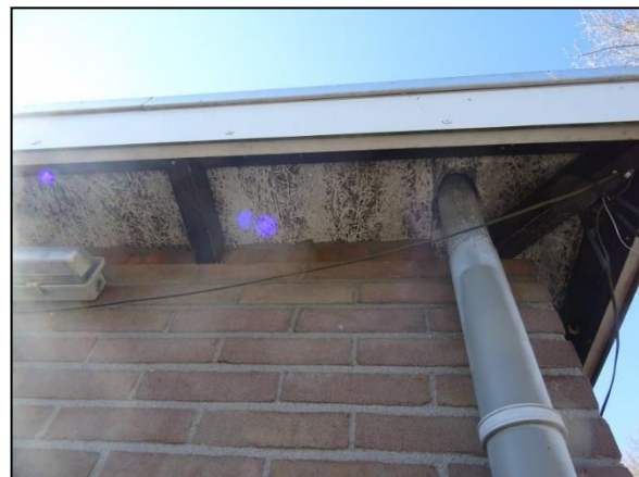
Figuur 22. Nauw aansluitende betimmering van de voetbalkantine.
