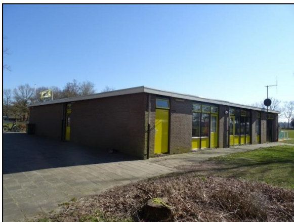
Figuur 21. Plat dak van de voetbalkantine.
