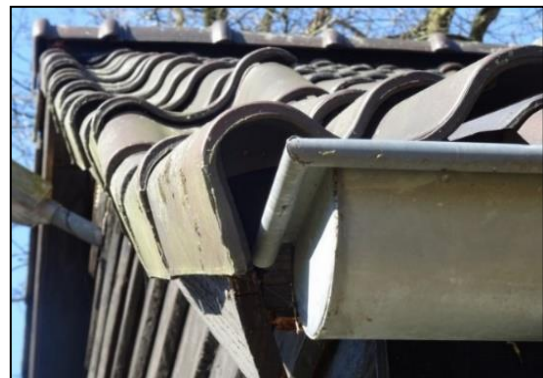
Figuur 29. Ruimte onder de dakpannen van het gebouw van de muziekvereniging.
