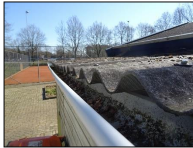
Figuur 24. Dankrand aanbouw tennis-kantine.
