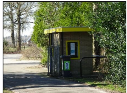
Figuur 14. Toegangshek en hokje (N) aan de noordkant van de onderzoekslocatie.
