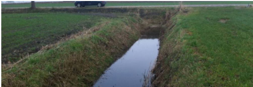
Figuur 15. Hemelwater wordt opgevangen in een sloot
