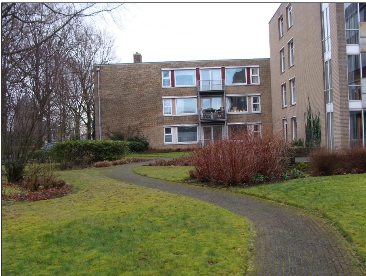
Figuur 9. Blokken rond groene ruimte, aan de achterzijde van het terrein, aan de zijde van de N374.
