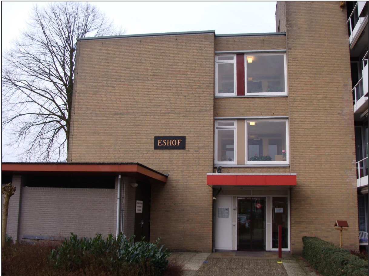
Figuur 6. Hoofdingang van gebouw de “Eshof”.
