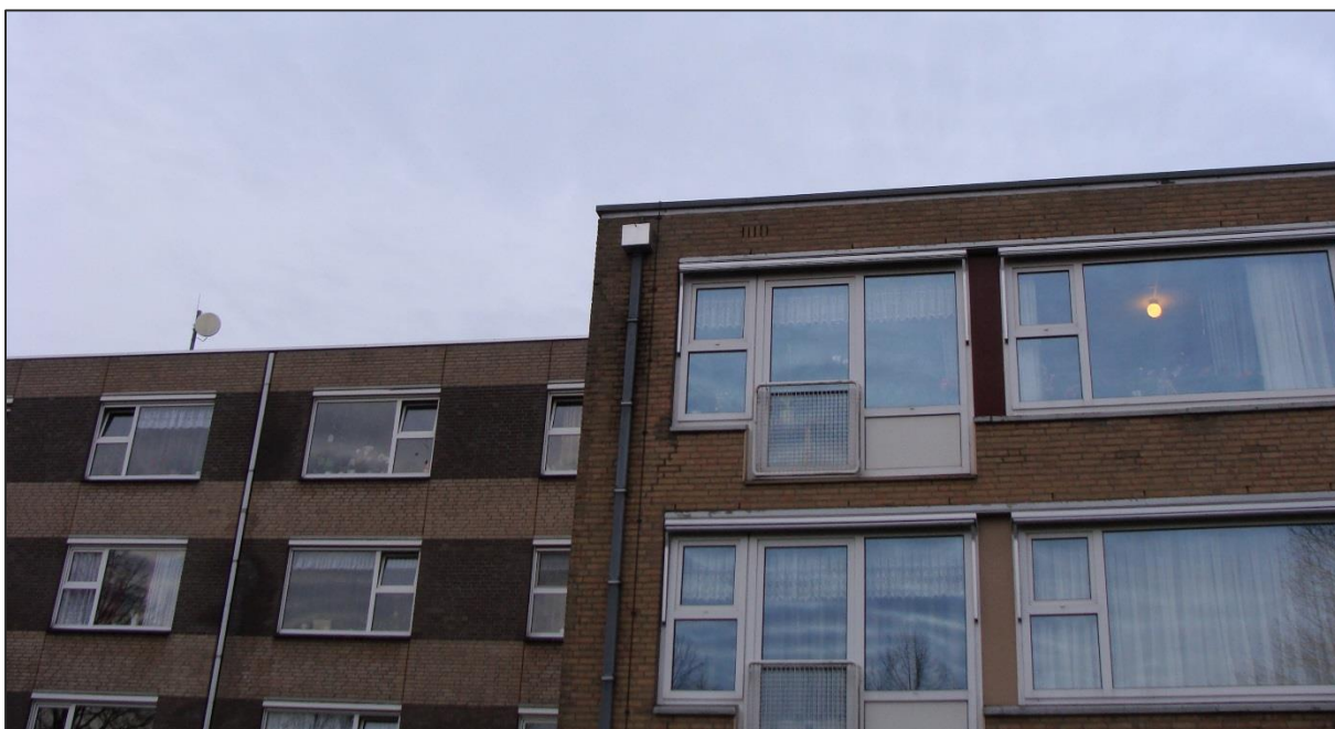
Figuur 13. Voorbeeld van de aanwezige stootvoegen in de muren van het tehuis.
