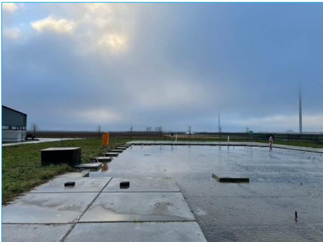
Figuur 1.2 : op de voorgrond het reeds verharde deel als locatie voor de bedrijfswoning.
