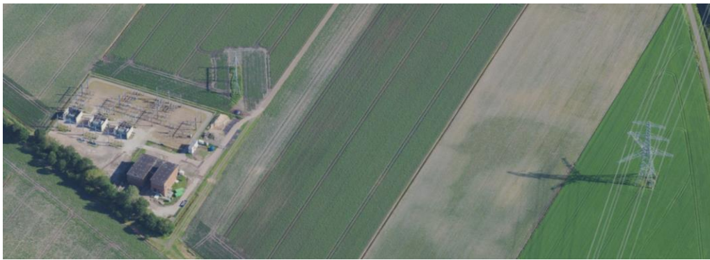
Figuur 2-2: Hoogspanningsstation Musselkanaal Zandberg (MSKZZ110) en mast 181 en mast 1 (portaal)
