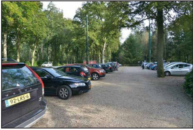
Parkeren in het bos met een waterpasserende verharding
