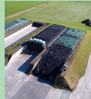
Sleufsilo's ingepast ket een grondwal als overgang naar het open landschap.
