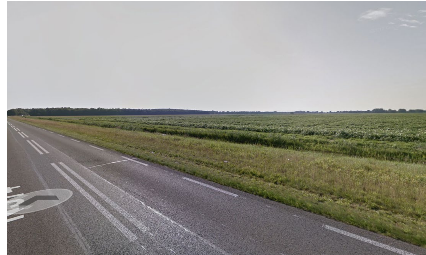
N374 westelijk zicht zich - locatie Nieuw Buinen
