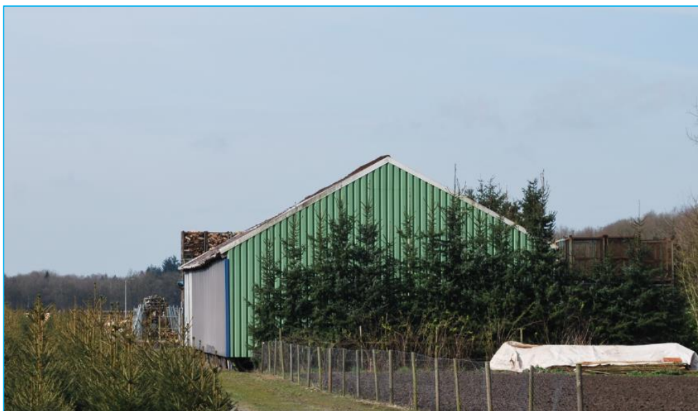
Zicht op de bestaande schuur – deze wordt opgeknapt worden om beter in het landschap te passen
