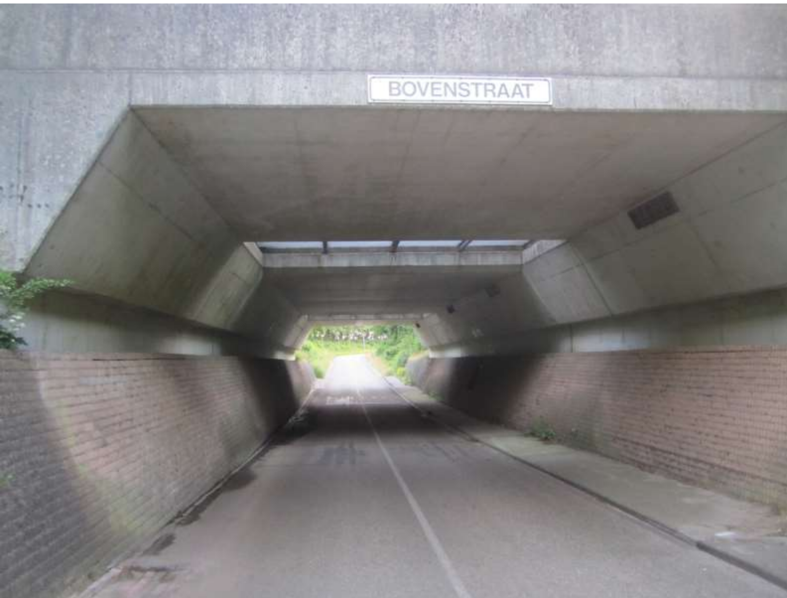
Foto 1. De tunnel onder de N34. Opname 1 juli 2013.
