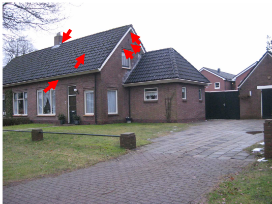
Figuur 3: Voorbeelden van (mogelijke) invliegopeningen in de 2-onder-1-kap-woning.
