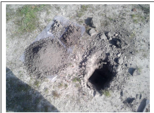
Foto 1. Opgegraven en gezeefd materiaal inspectiegat C01
