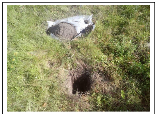
Foto 10. Opgegraven en gezeefd materiaal inspectiegat C09
