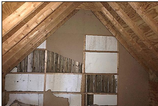
Afbeelding 2.7. Zolder met kieren.
