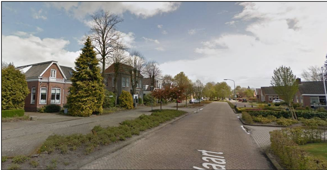
Parallelstructuur ter plaatse van het plangebied: Havenkade (midden met hoofddrijbaan), met links een groenstrook met parkeervoorzieningen en daarnaast de Vaart. (bron: Google Streetview).
