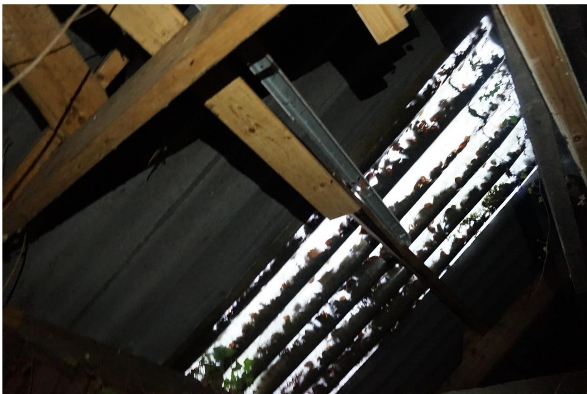
Figuur 2.9. Dak zonder dakbeschot van schuurtje langs perceelsgrens met Stationsstraat 11.
