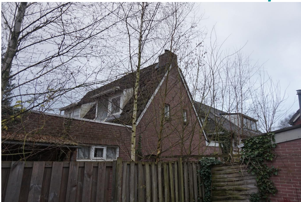
Figuur 2.6. Achterzijde bebouwing Stationsstraat 9.
