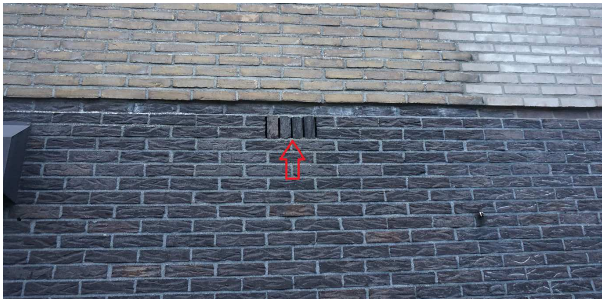
Figuur 5.3. Ventilatiegaten in spouw zuidgevel Stationsweg 5.
