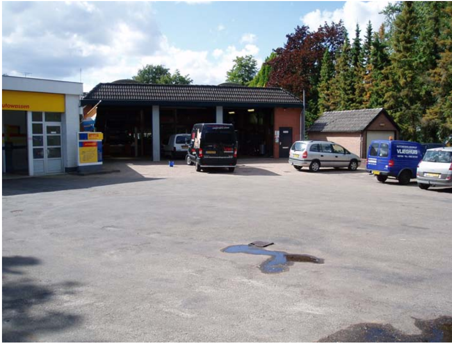
Figuur 2: Gieten, Stationsstraat 5, 7 en 9: Foto van het plangebied. De foto is richting het zuidwesten genomen.
