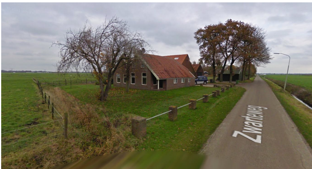
Perceel Zwarteweg 1, gezien vanuit westelijke richting (bron: Google Streetview)
