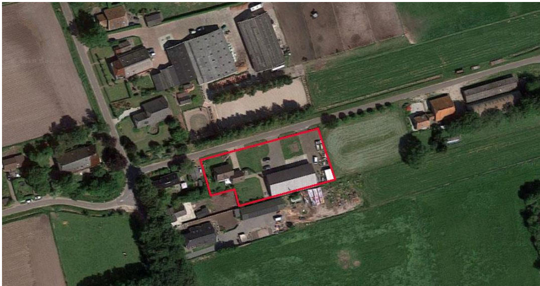
Afbeelding 3: De huidige bedrijfsbebouwing op het perceel Verlengde Grensweg 2.
