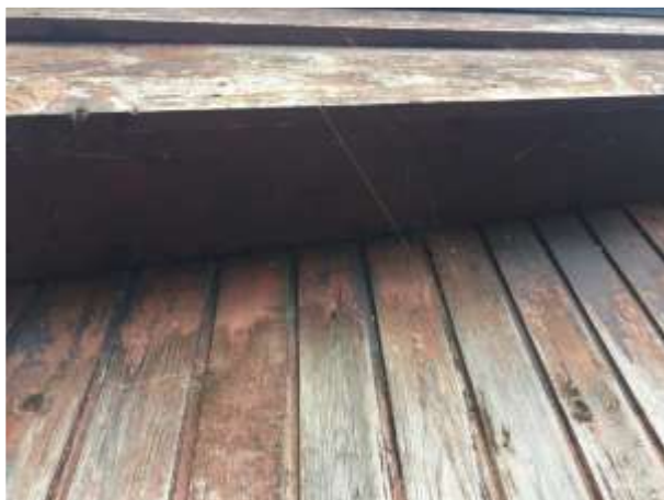
Foto links; De betimmering van de dakrand sluit naadloos aan op de buitengevels.
