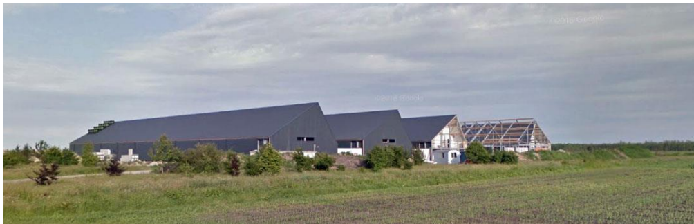
Afbeelding 2: De bedrijfsbebouwing tijdens de bouw.
