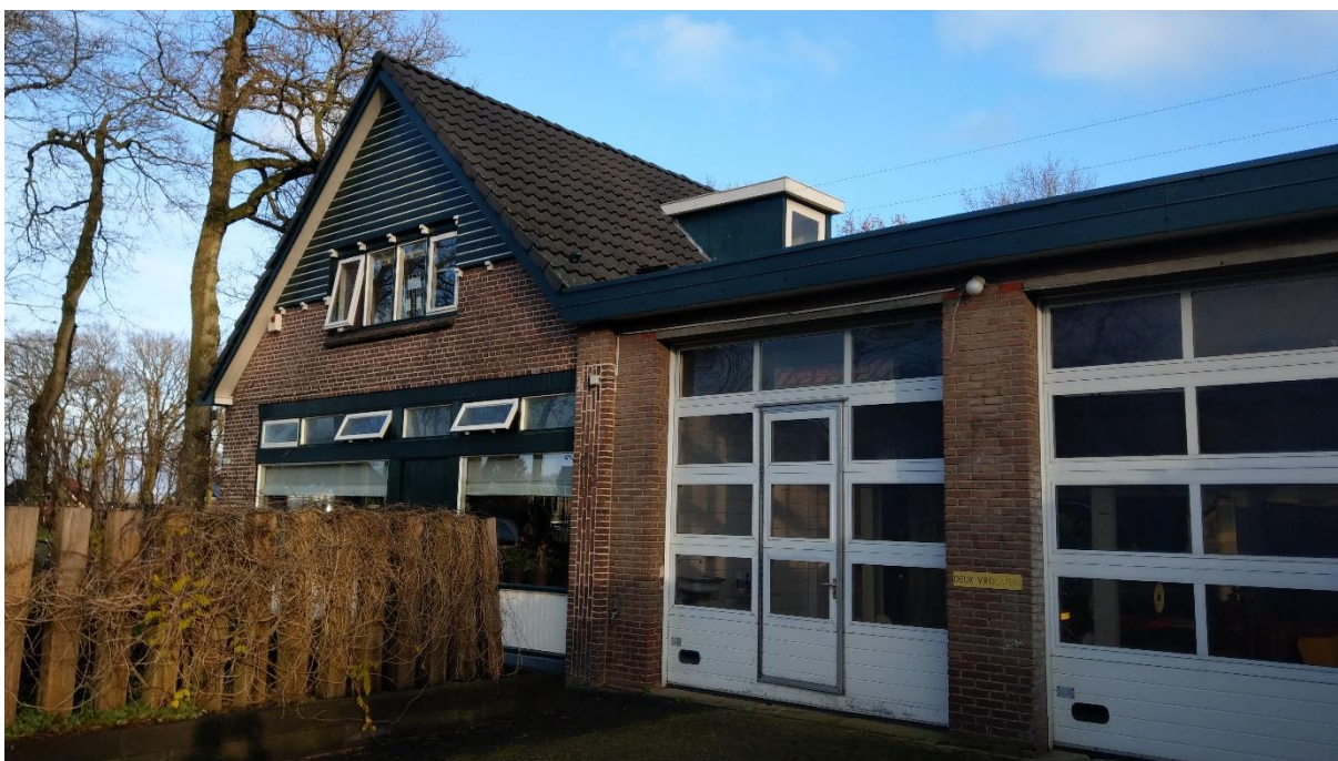
Figuur 2: Beeld van de te slopen woning met naastgelegen garage (situatie op 28 december 2020).
