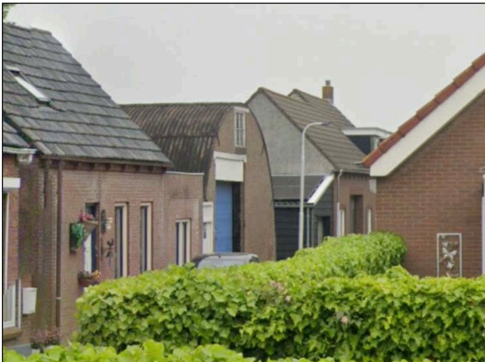
Figuur 5 Aanzicht loods bestaande situatie
