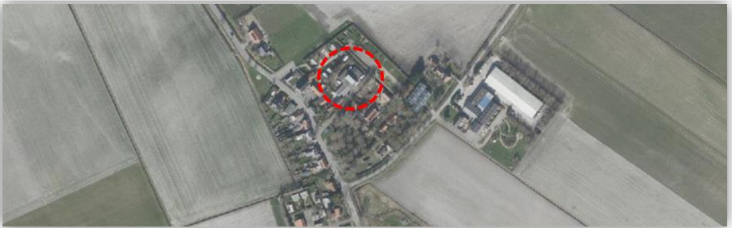
Figuur 2 Luchtfoto Looperskapelle met in het rood aangegeven de projectlocatie (bron: Verseput Bouw en Milieutechniek B.V.).
