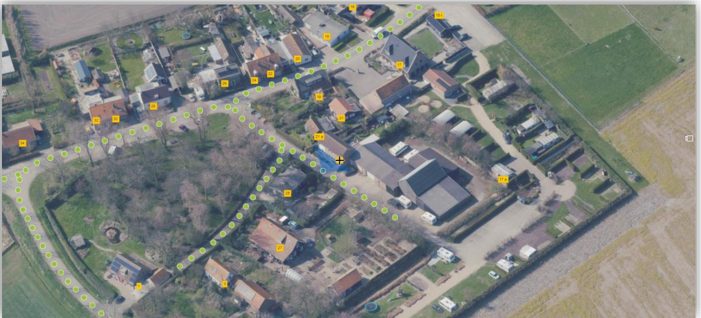
Figuur 5 Luchtfoto planlocatie (bron: Street Smart by Cyclomedia).
