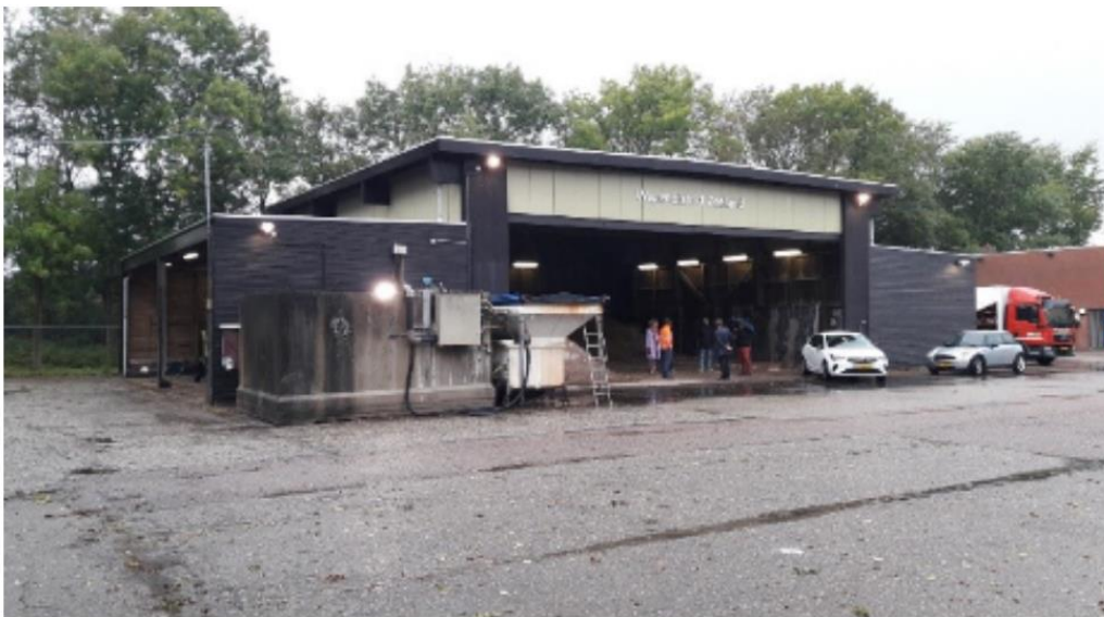
Figuur 2.1-3 Huidige zoutloods met overkapping
