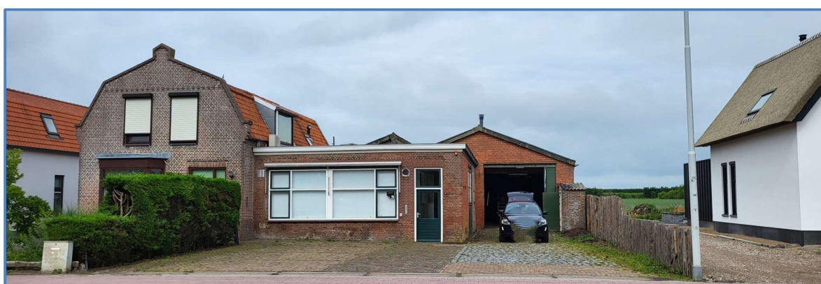
Huidige situatie Lange Blokweg 19a. Nota Bene: de woning links op de foto valt buiten het project (en blijft staan)
