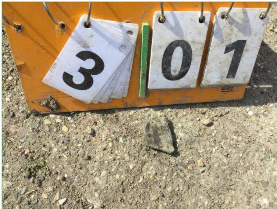
Foto 7 Asbestverdacht materiaal sleuf 301
